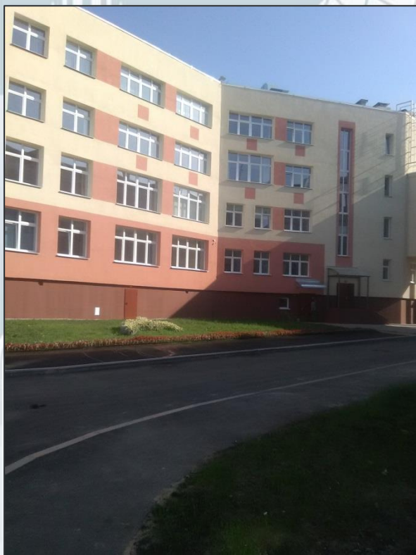
Пристройка к зданию СОШ №43
